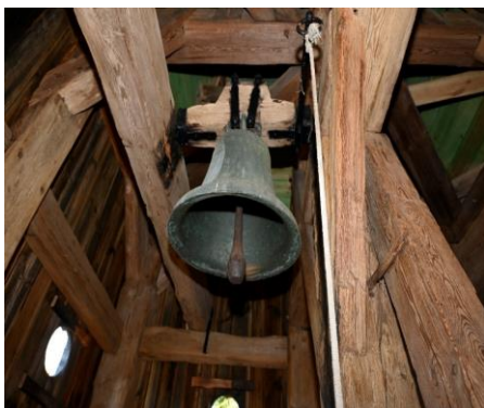
Zdjęcie 5. Drewniana konstrukcja wieży po renowacji
