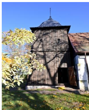
Zdjęcie 6 Elewacja południowa wieży
